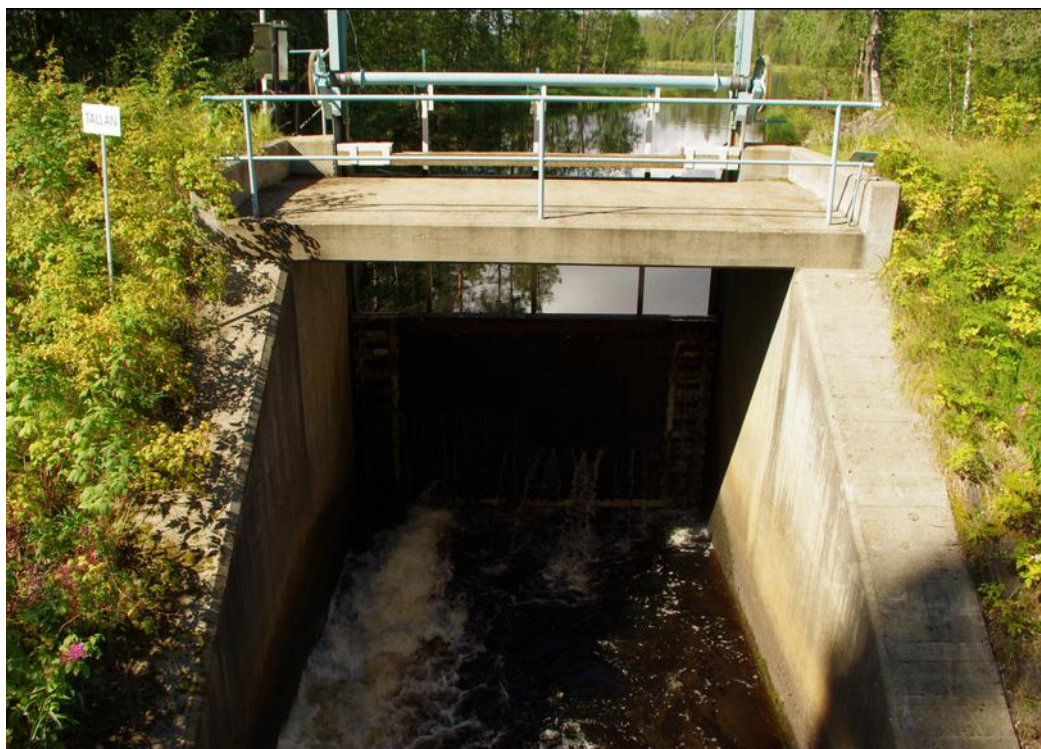
Figur 8: Minimitappning genom bottenöppning i Tallträskdammen, 14/8-2013. Foto: Jan Åberg.
