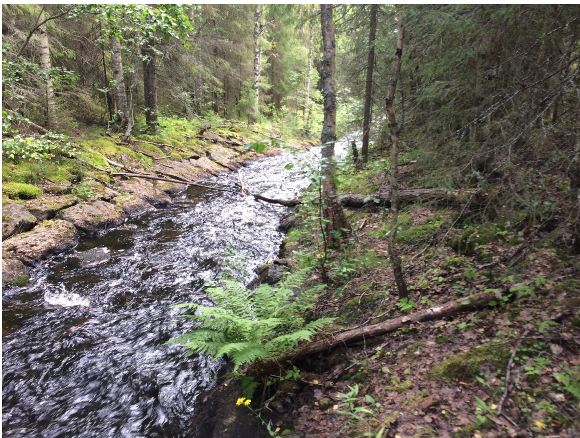
Illustration 2: Släntmur nedströms Stavarforsen (objekt nr 40).
